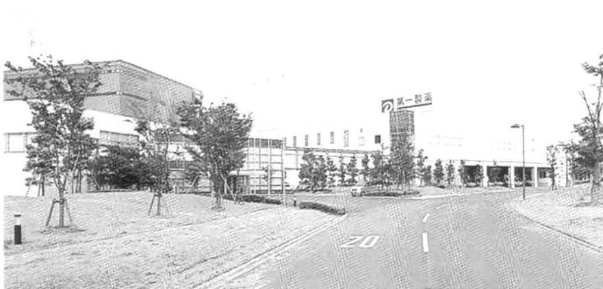
东京物流中心。 占地面积: 33999m 2 建筑面积: 8885m 2
